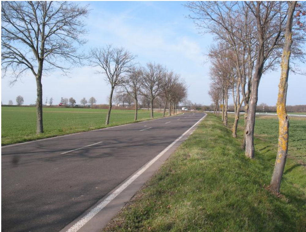
Der alte Verlauf der B 56 endet als Sackgasse. Hinter ihrem Ende weicht die neue Trasse (helle Linie rechts) vom alten Verlauf ab. (24.3.2021)
