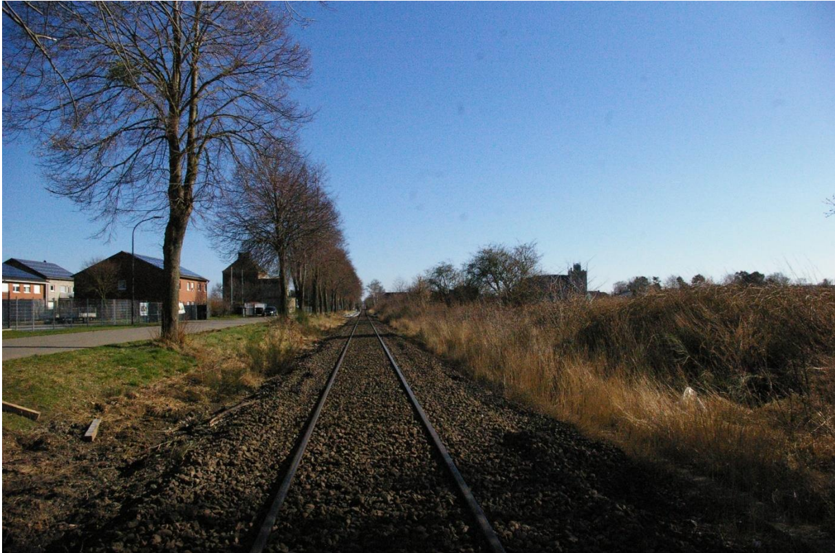
Abbildung 5: Bahntrasse von Baumreihe und bewachsener Böschung an der Ostseite des Plangebietes; Aufnahme Verf. 27.02.2022
